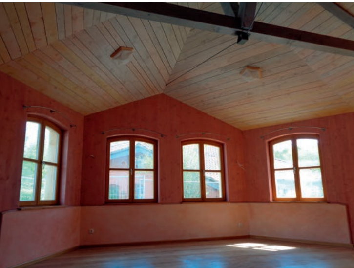
Krippenhaus – der Anbau im Waldorfkindergarten Melle besteht aus einer Vollholz – Konstruktion (NUR-HOLZ) Farbkonzept: Götz Keitel; Objektplanung: Architektur- und Ingenieurbüro Tiarks
