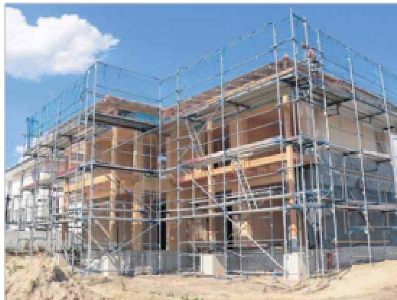
Der Rohbau war in fünf Tagen aufgebaut, dank vorproduzierter Bauteile. Fotos: Norbert Wiegand
